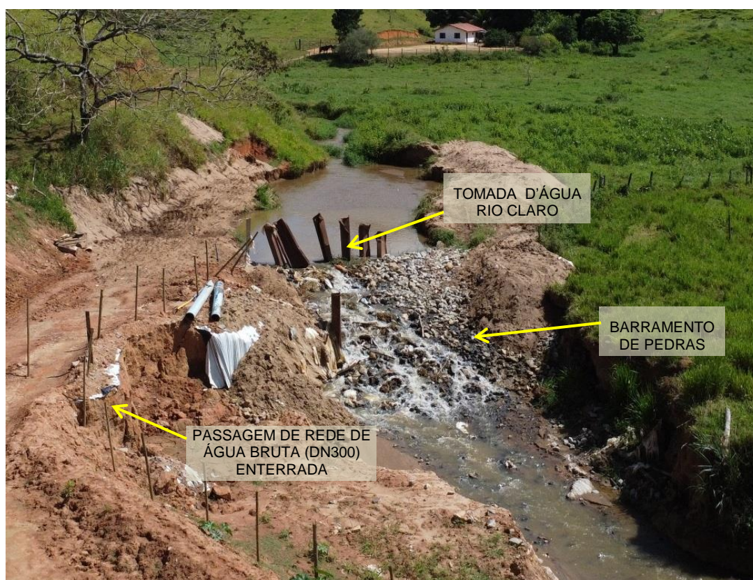
Figura 2 – Tomada d'água provisória no córrego Rio Claro.
